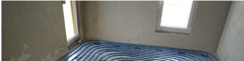
Izvođenje podnog grejanja u objektu
