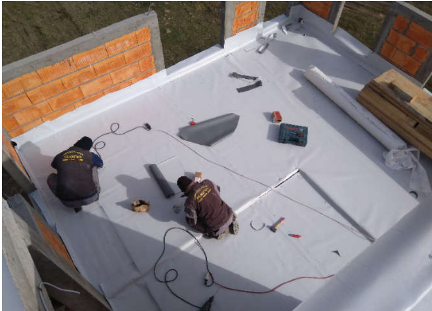
Polaganje PVC membrane preko ploče ravne krovne terase
