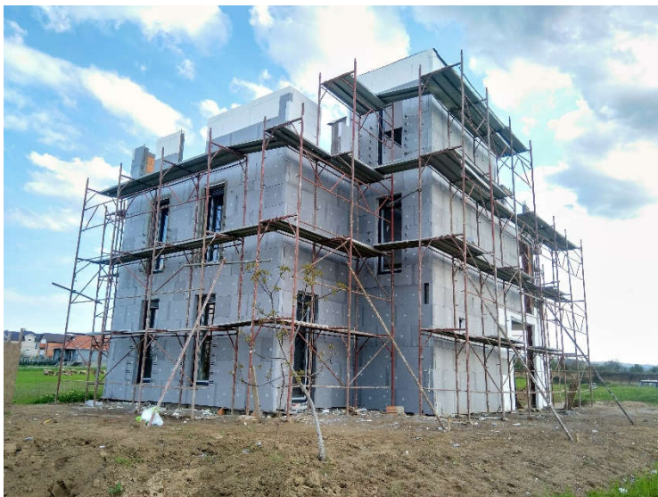
Termoizolacija objekta - grafitni stiropor d=10cm
