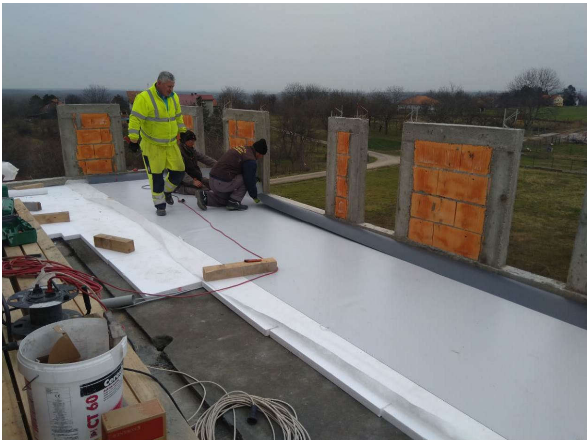
3 - Hidroizolacija krovne terase - PVC membrana
