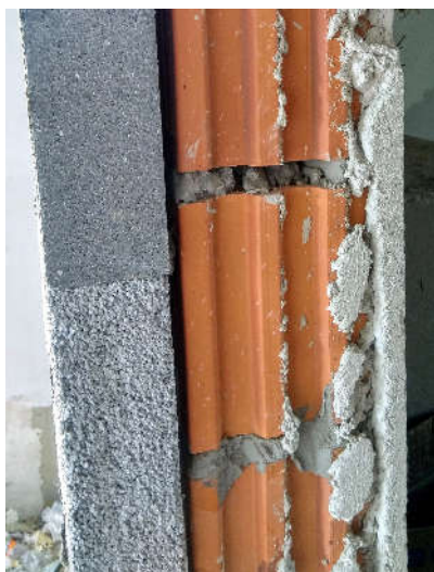
Struktura fasadnog zida (neopor 10cm, Klima blok 20cm, malter 1.5cm)
